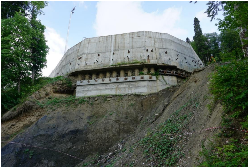
Рисунок 5 – Обнажение буронабивных свай фундамента СТ-3
